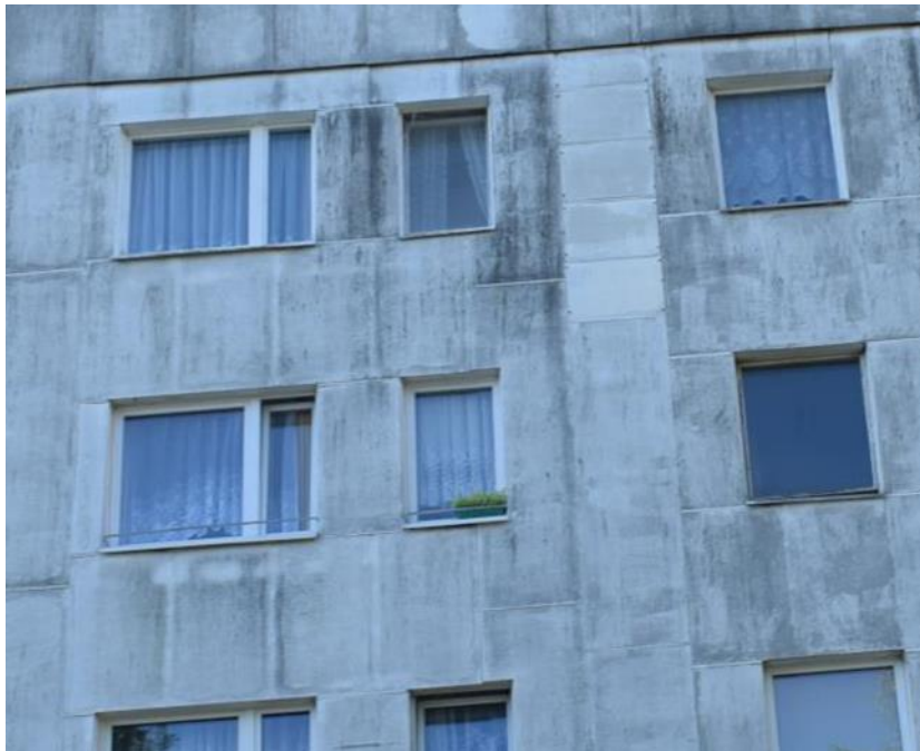
Fot. 2 Płyta azbestowa płaska stosowana w budownictwie na przykładzie bloku mieszkaniowego w dużym mieście wojewódzkim. Zdjęcie własne.
